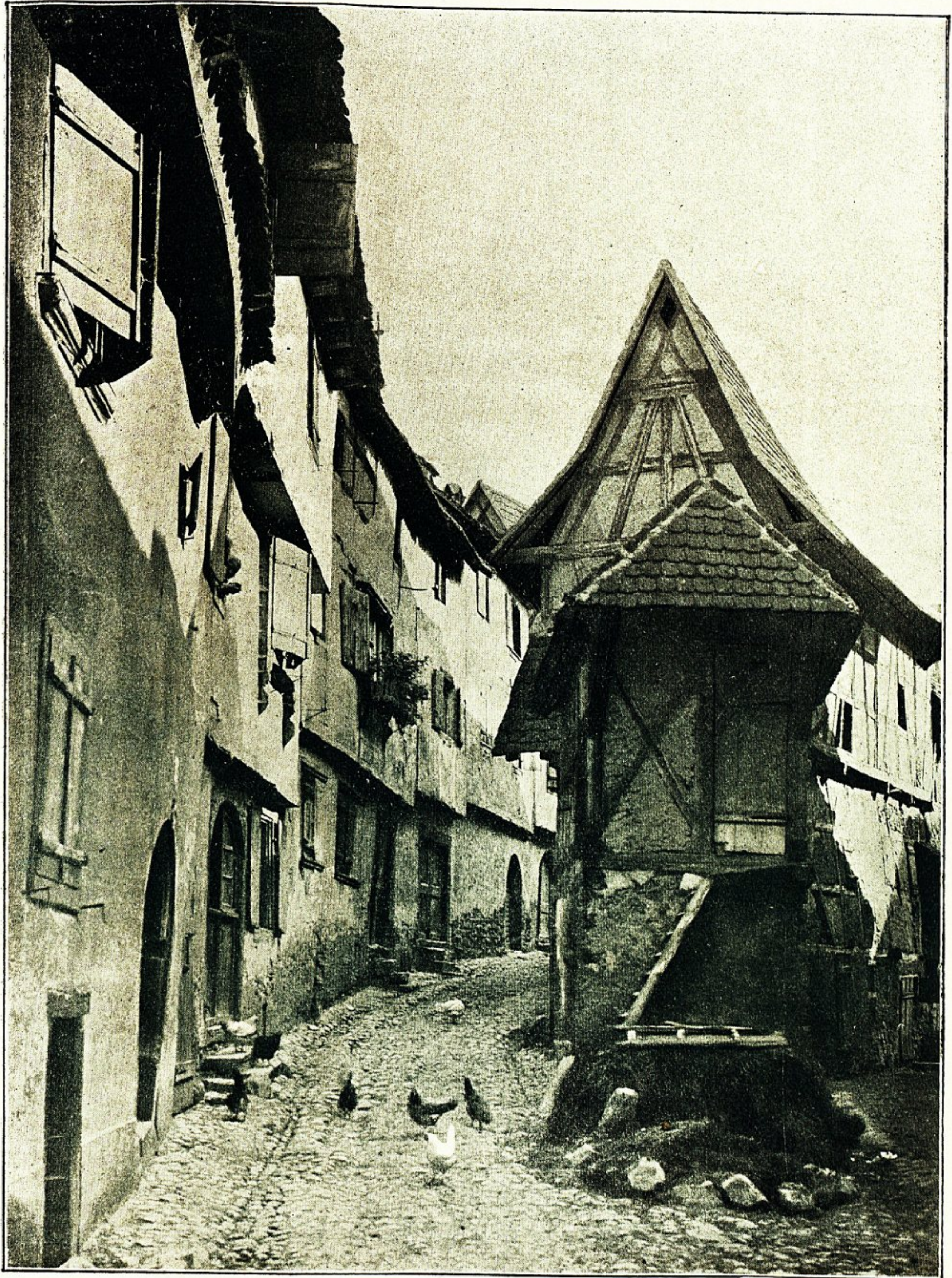
Graben zu Egisheim.
